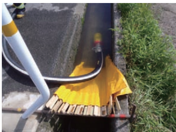
＜使用方法2＞ 道路標柱、とび口、バールを使用
